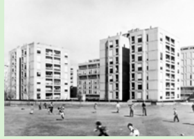
© INA AS, Fondo Storico Immobiliare
