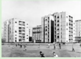
© INA AS, Fondo Storico Immobiliare
