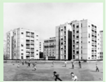
© INA AS, Fondo Storico Immobiliare
